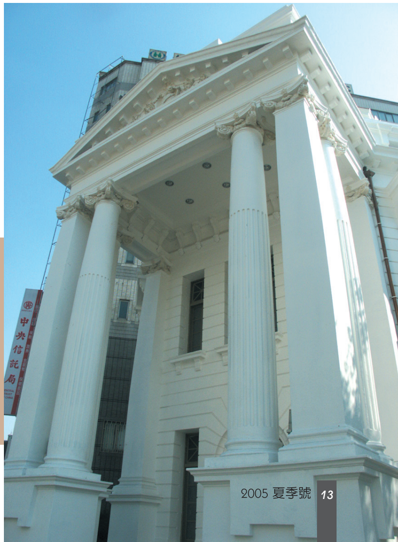
市役所修復完成仿巴洛克建築入口門廊。
