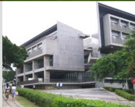
上圖：路思義教堂 下圖：人文大樓 左圖：基礎科學實驗室
