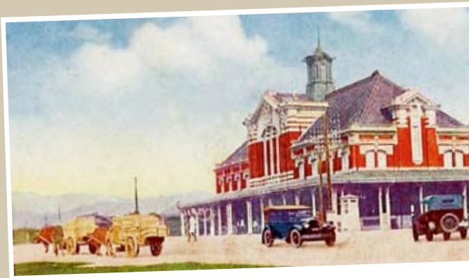
日治時期的台中火車站
