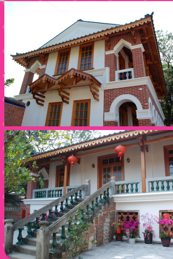
▲整修過後的五桂樓，重現了日治當時 1905 年的面貌。
