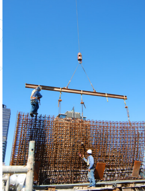
■ 工人進行曲牆空中校正定位。
