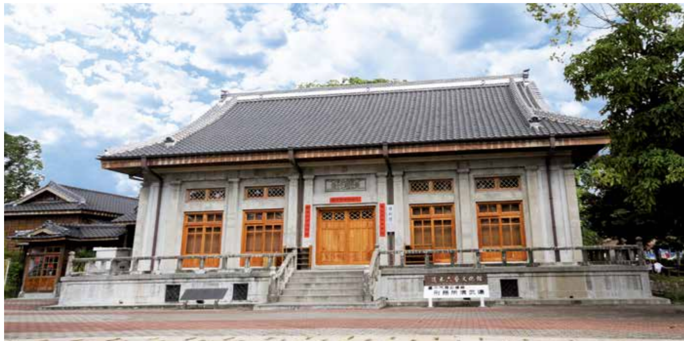
刑務所演武場，為臺中市西區的歷史建築。
