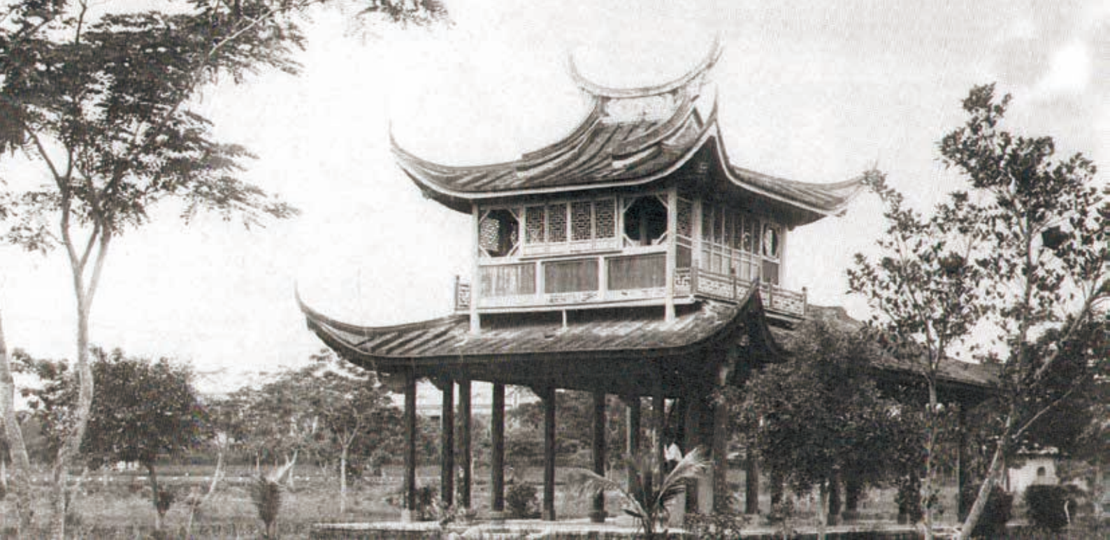
儒考棚的主樓被遷移到水源地，命名為「湧泉閣」，但現今已損毀。
