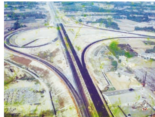
1974年興建中的中山高速公路豐原交流道匝道
