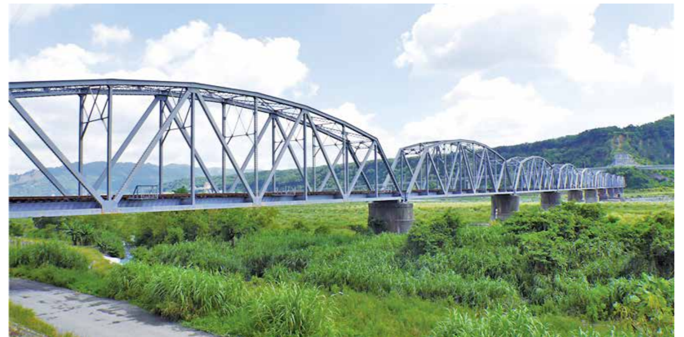
大安溪雨季時流量不穩容易暴漲，因此興建工程格外困難。
