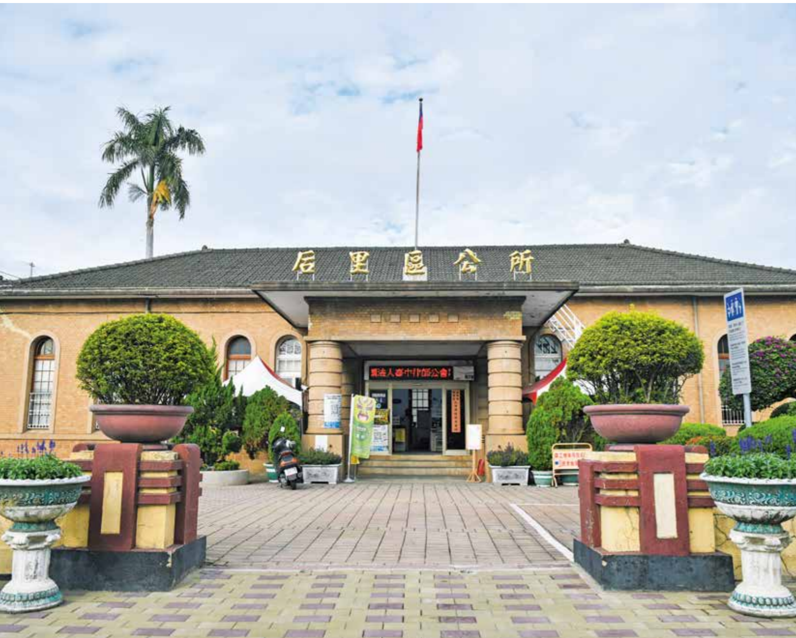
市定古蹟內埔庄役場（今后里區公所）1934年竣工至今，經歷20世紀兩次大地震仍屹立不搖。
