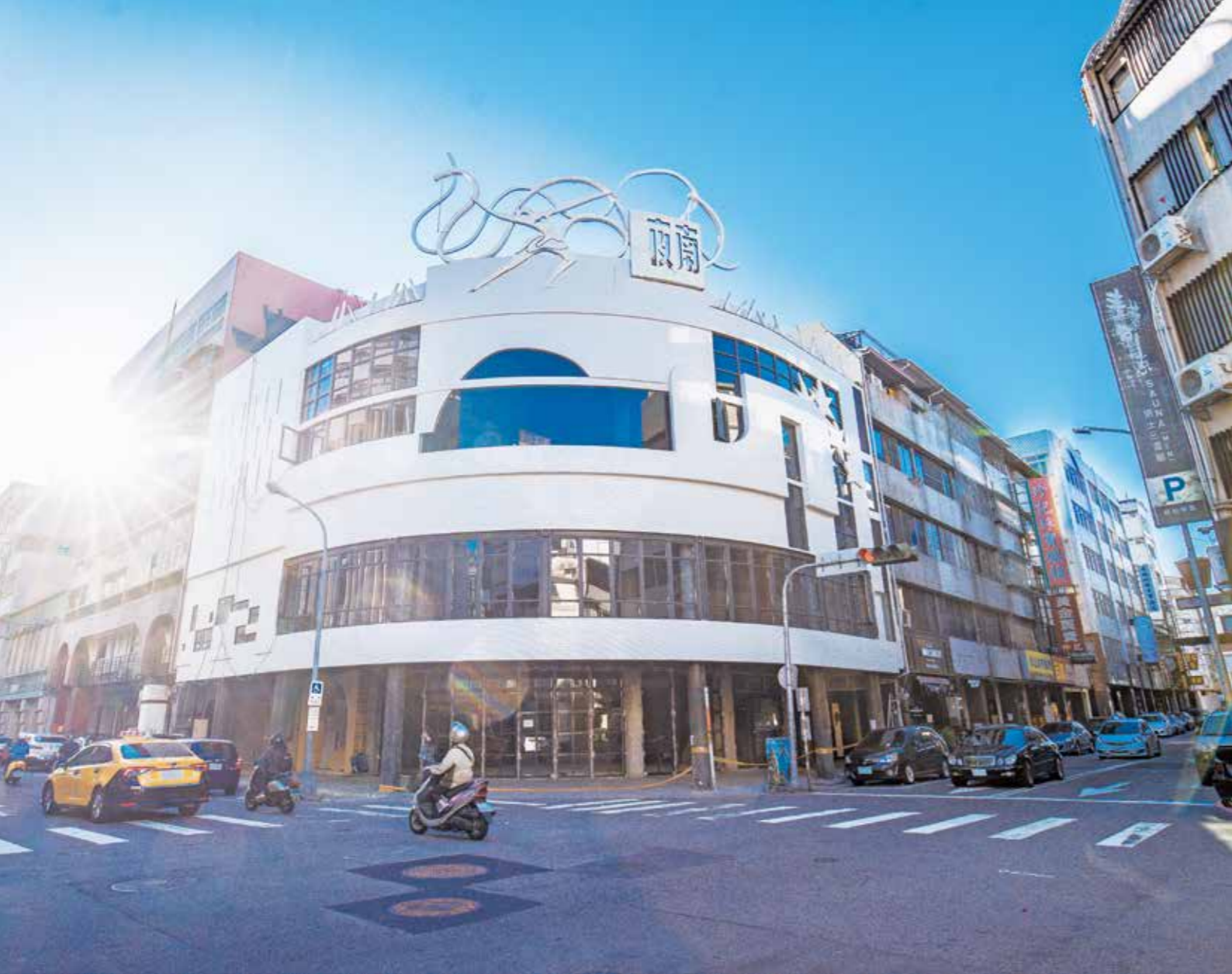
王水河所設計的南夜大舞廳目前內部正在進行改建，外觀仍保有王水河設計的雕飾。
