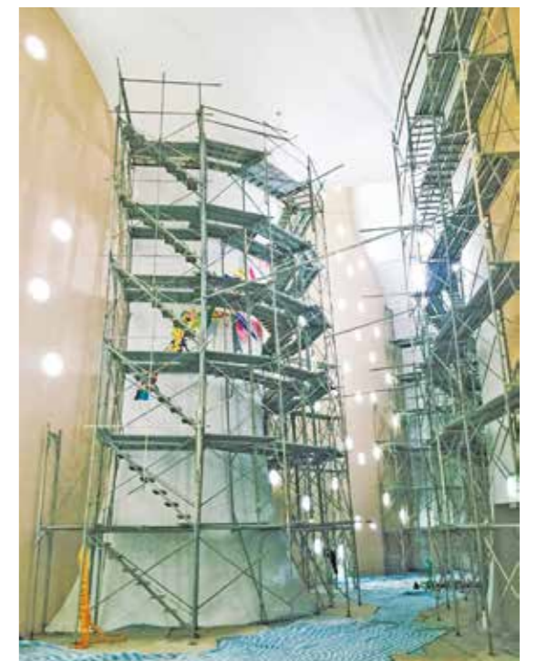
在約4層樓高的鷹架上製作作品《翩翩》相當挑戰膽識
