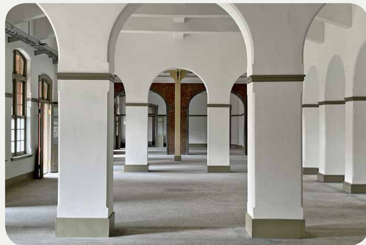
臺中州廳圓拱門粉刷線腳完成後，顯現出優美的線條。
