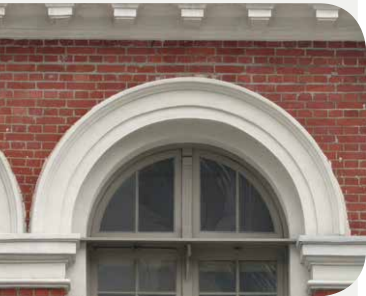
外牆圓窗線腳分層施作完成外觀
