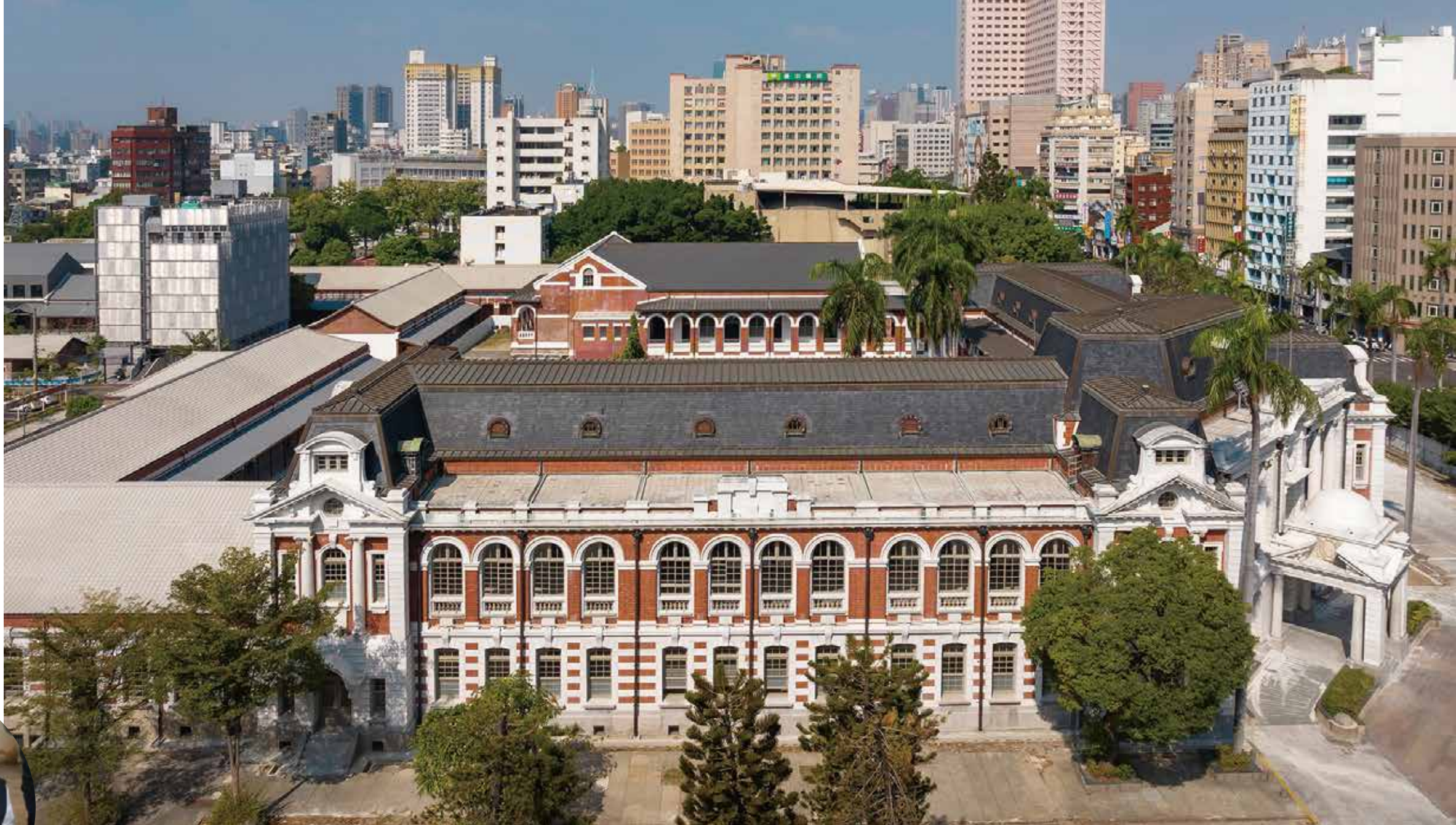
由南翼俯瞰臺中州廳建築
