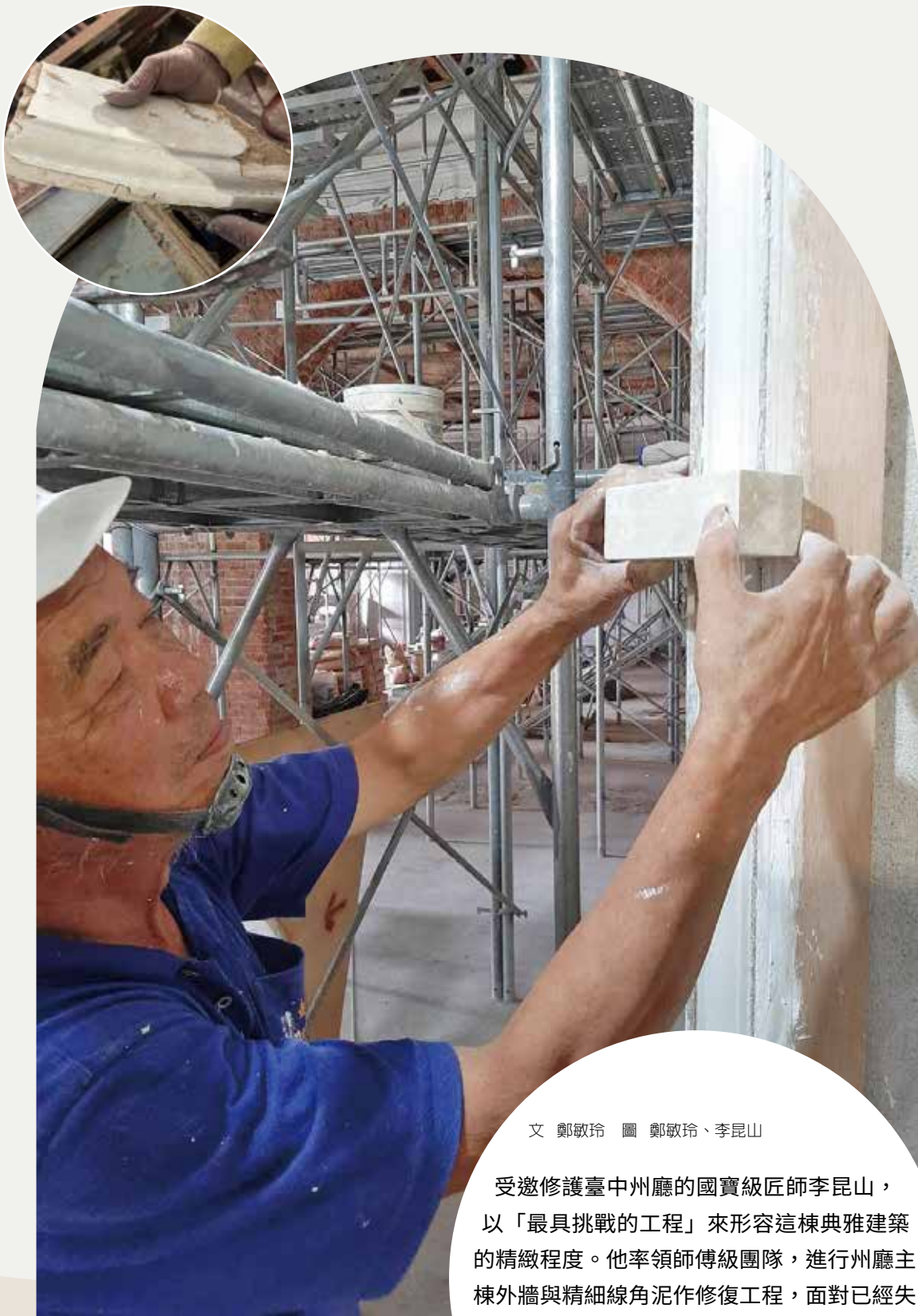
上圖 | 損壞的泥塑線腳遺構作保留為後續仿作依據 下圖 | 具有謙虛及不服輸的人格特質，李昆山對於古蹟修復始終保持敬畏與堅持的精神。
