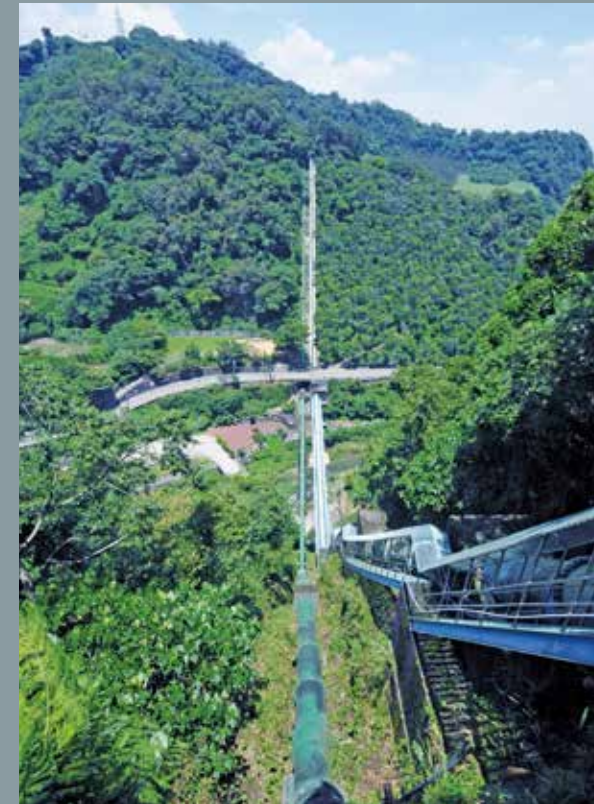
新社白冷圳 2 號倒虹吸管（攝於 2026 年 5 月）
