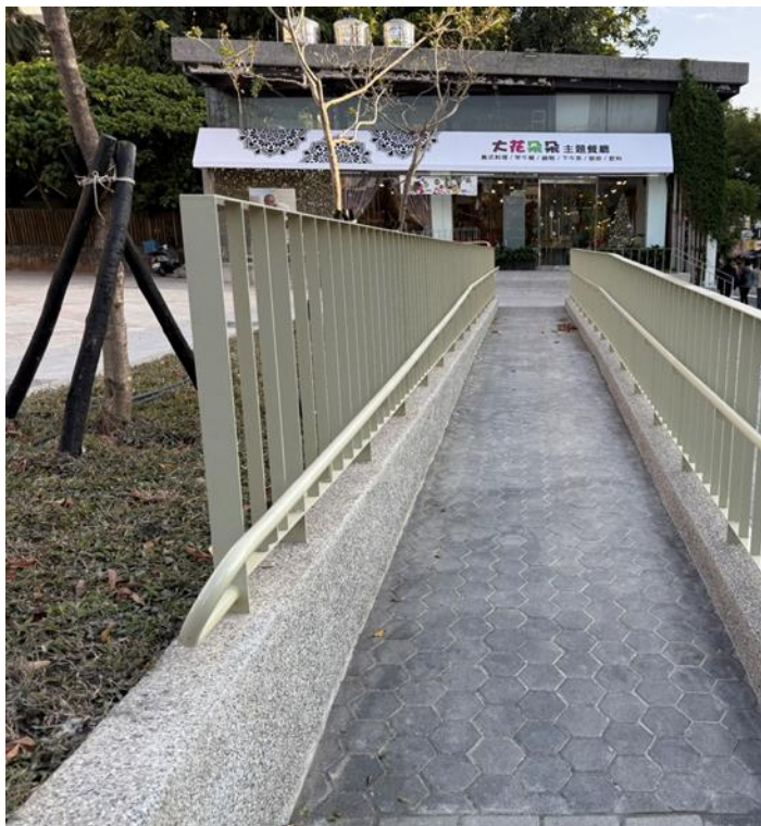
增設無障礙坡道
